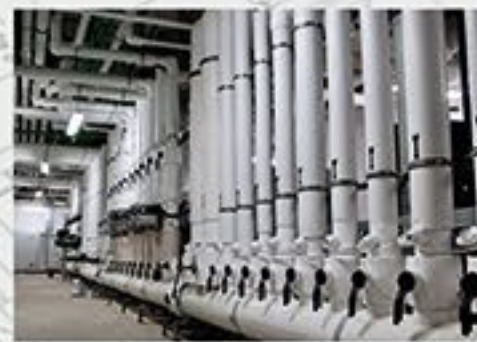
Előreszigetelt Aquaplust Prins gépház 5"-os hotelben
