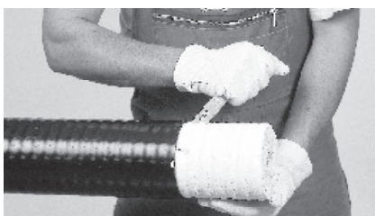
5 A szigetelést a kimért helyen (X, Y, Z) vágja vissza vagy távolítsa el. Figyelem: a haszoncső ne sérüljön!
