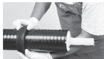
6 Helyezze fel a tömítőgyűrűt.
